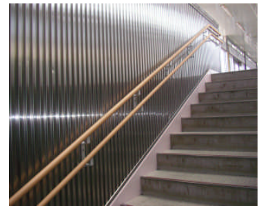
階段手摺の二段化
