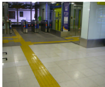
誘導ブロック
